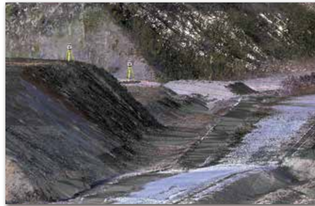
【点群】 Trimble SX10と取得した点群を3D表示で確認
